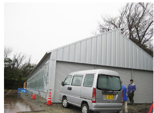
完成したハウス牛舎 全景
