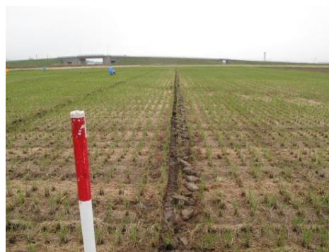
写真1 籾殻補助暗きょの施工作業（左）とほ場内の表面作溝（右）
